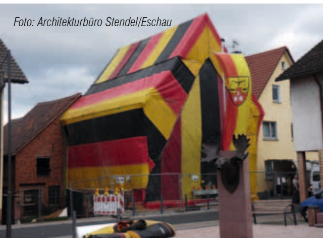
Eine Spezialfolie verhindert den Gasaustritt.
