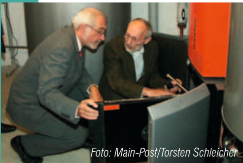
Foto: Main-Post/Torsten Schleicher Walter Sattes vom Ingenieurbüro Sattes erläutert die neue Heiztechnik.
